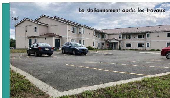
Un autre problème a apparu durant les inondations au printemps 2017 où tout le stationnement se trouvait sous l'eau. HOM a donc décidé de refaire l'infrastructure et de relever le niveau du stationnement d'environ 1 mètre. Après l'achèvement des travaux, quand les inondations ont frappé la région à nouveau en 2019, tout le stationnement était utilisable à 100 %.
